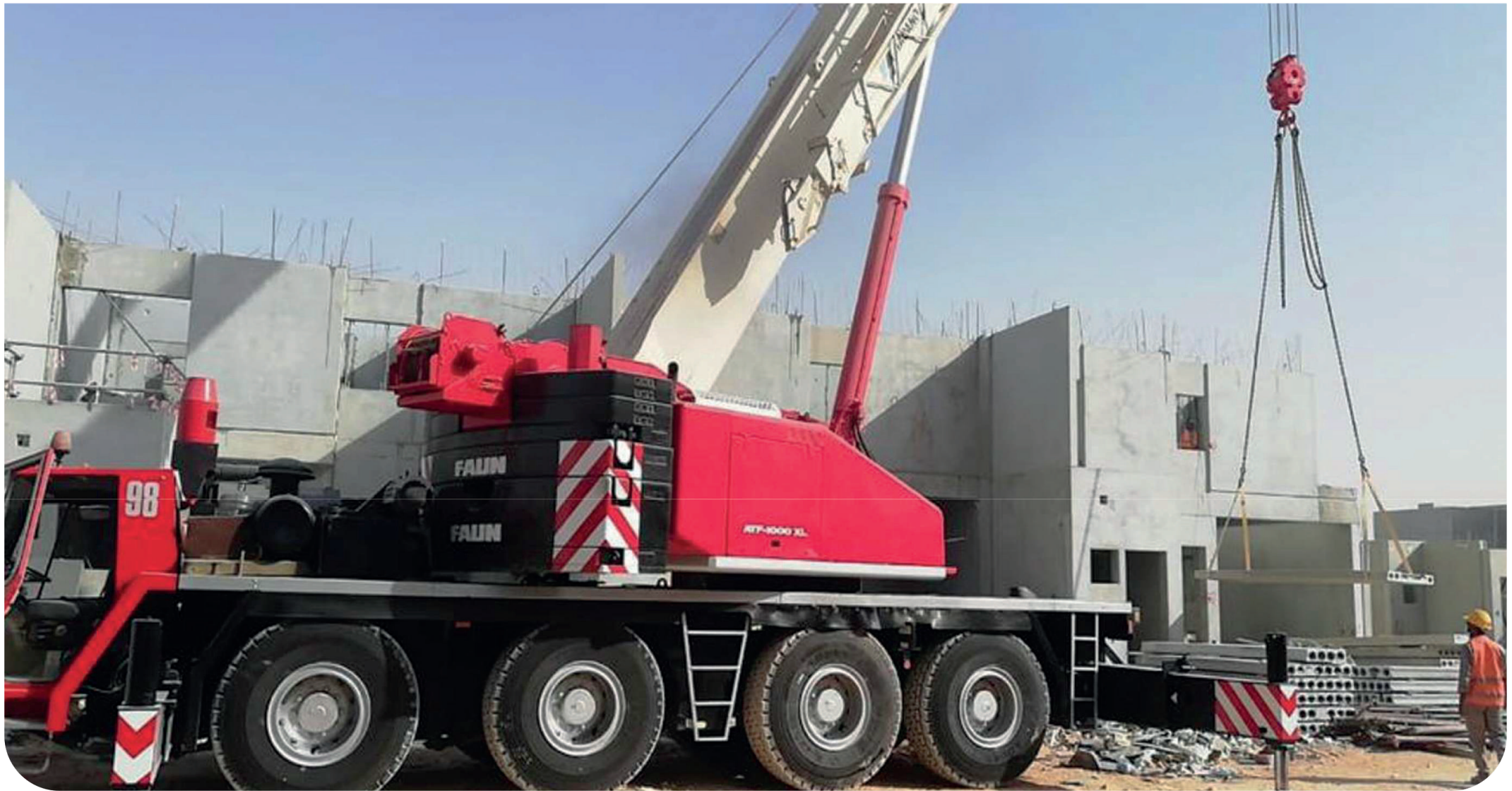
مشروع إسكان ضاحية خزام - أعمال بريكاست - منطقة الرياض
