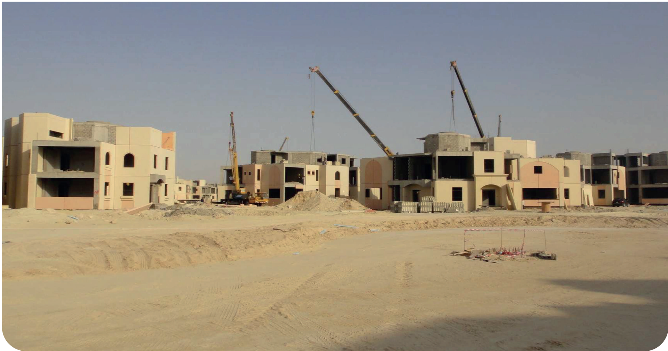
مشروع جامعة الملك فيصل - أعمال بريكاست - منطقة الاحساء
