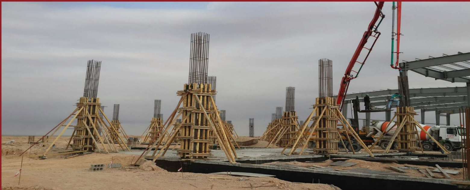
أعمال خرسانية بمول العثيم بحفر الباطن
