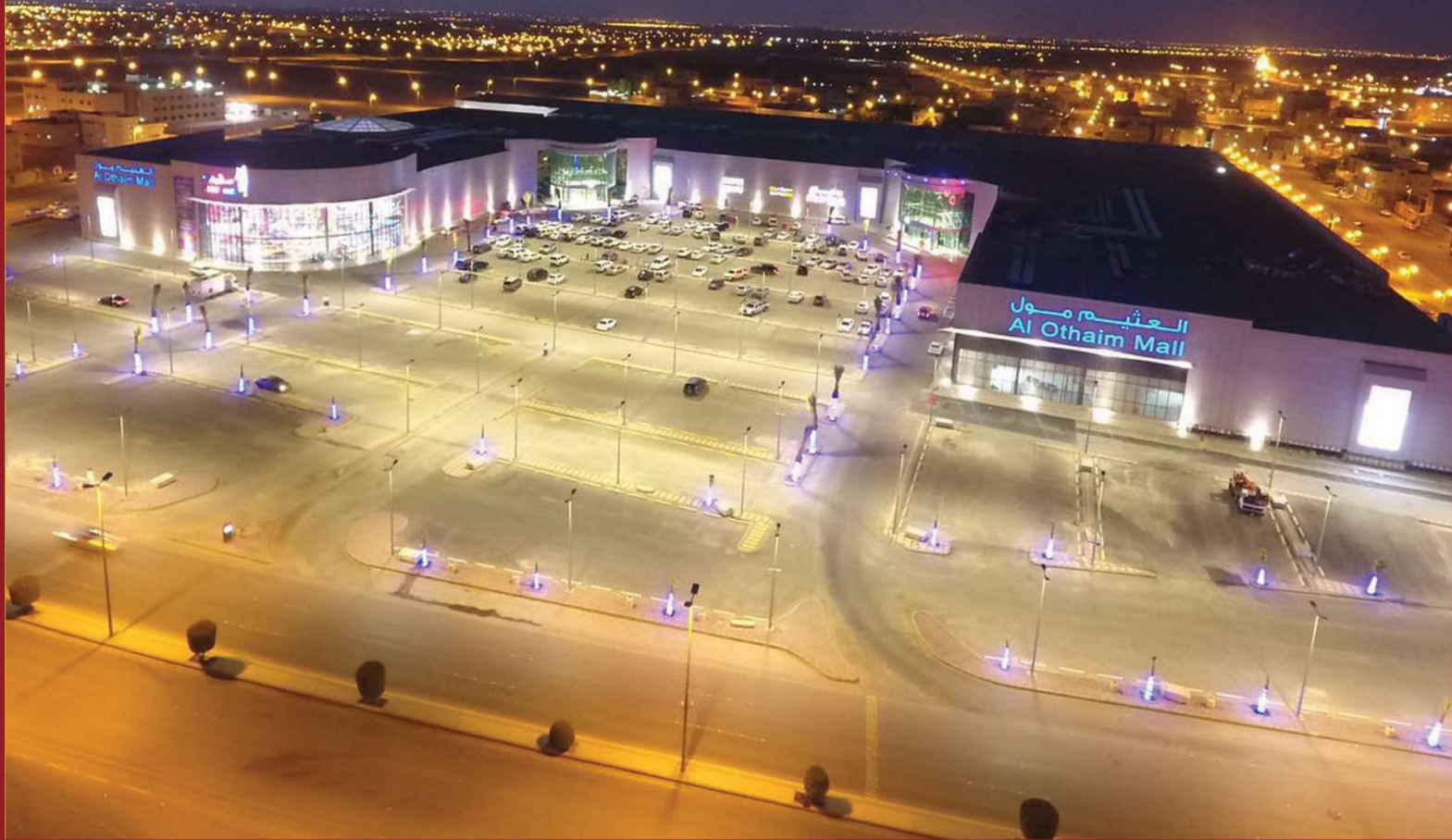
أعمال المسابح و الطرق و اللاندسكيب
