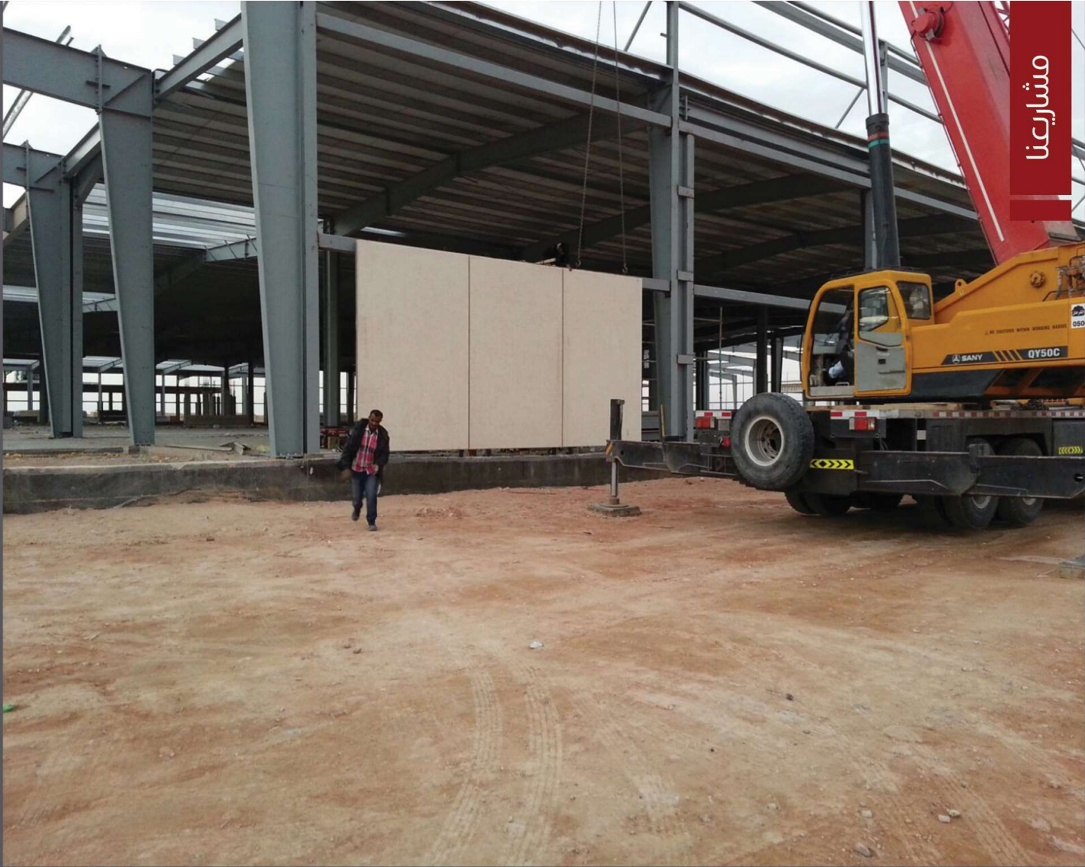
أعمال التركيبات بمول العثيم - حفر الباطن
