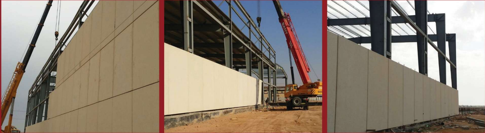
أعمال التركيبات بمول العثيم - حفر الباطن
