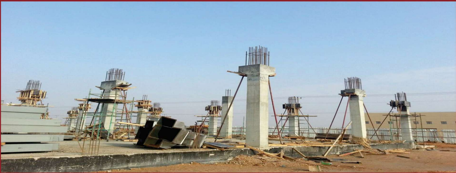
أعمال خرسانية بمول العثيم بحفر الباطن
