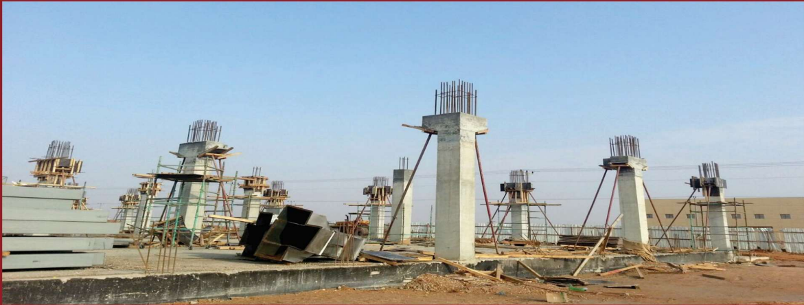
أعمال خرسانية بمول العثيم بحفر الباطن
