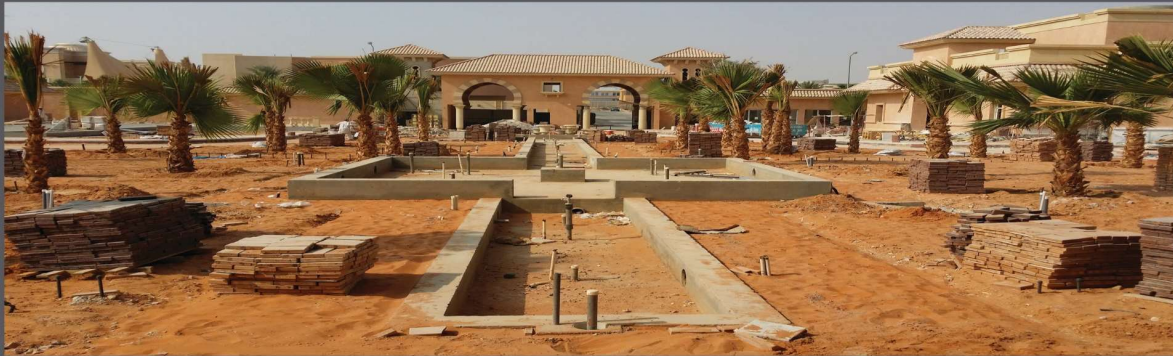
أعمال المسابح و الطرق و اللاندسكيب
