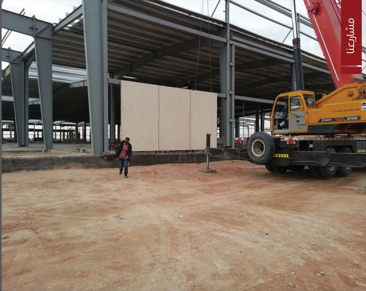
أعمال التركيبات بمول العثيم - حفر الباطن
