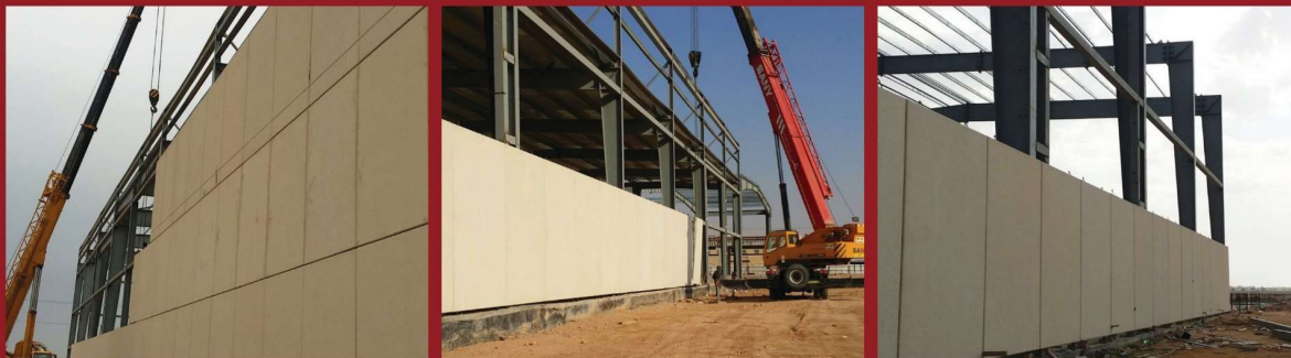
أعمال التركيبات بمول العثيم - حفر الباطن
