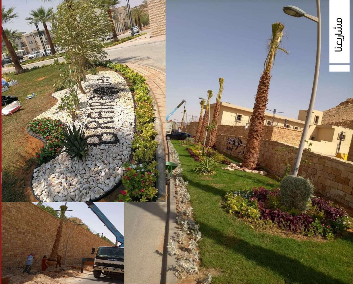
أعمال المسابح و الطرق و اللاندسكيب
