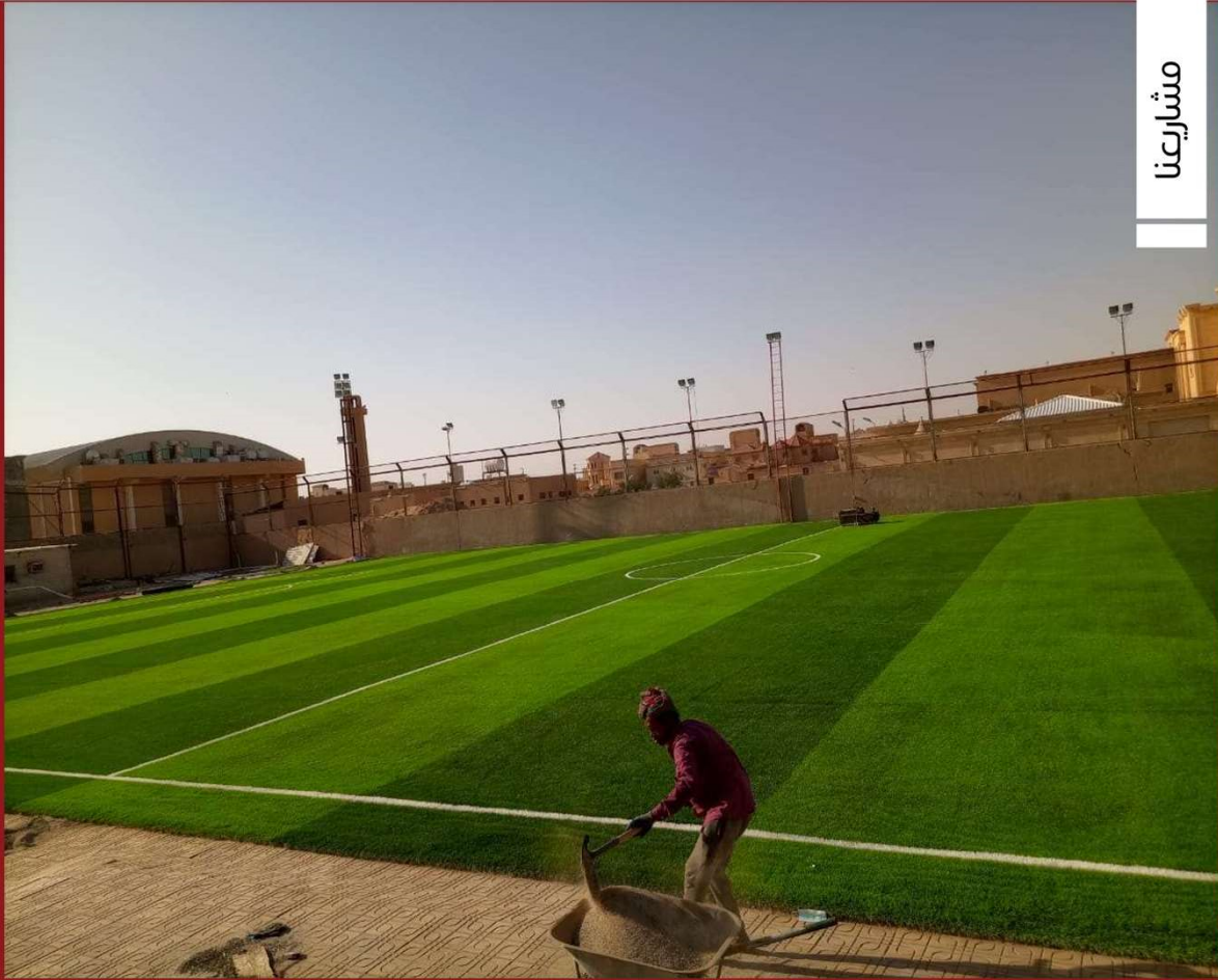
أعمال المسابح و الطرق و اللاندسكيب
