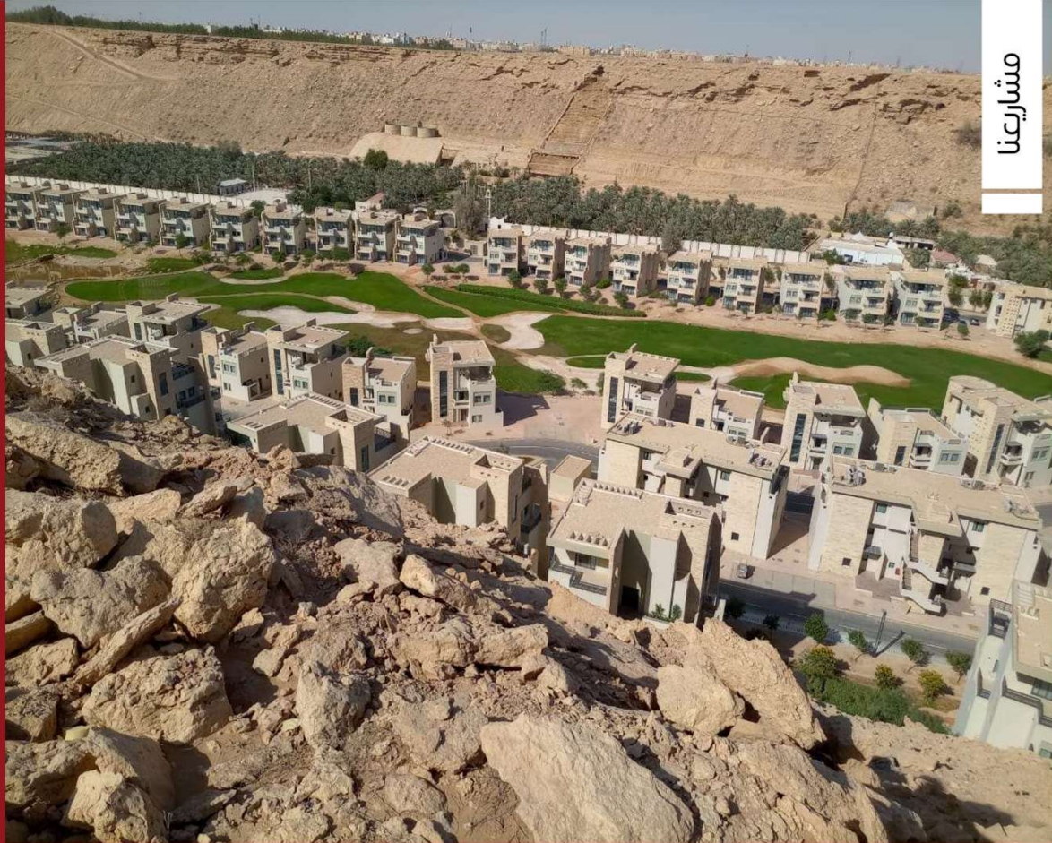
أعمال المسابح و الطرق و اللاندسكيب
