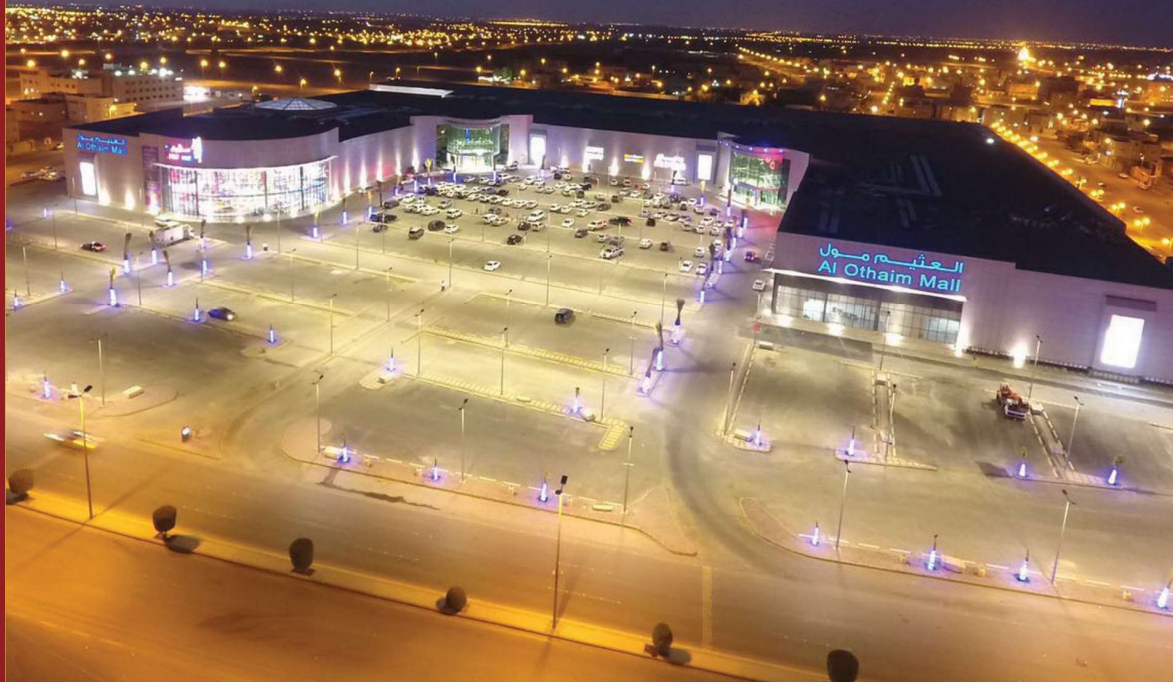
أعمال المسابح و الطرق و اللاندسكيب
