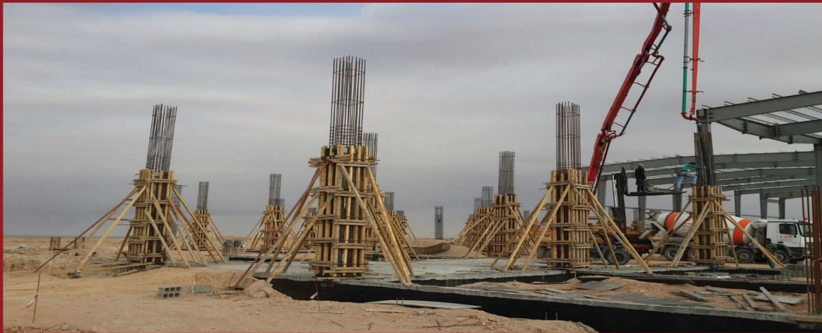
أعمال خرسانية بمول العثيم بحفر الباطن
